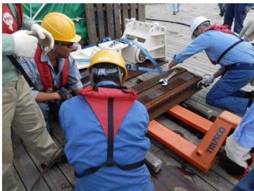
写真 12-1 : アンカーの組み立て
